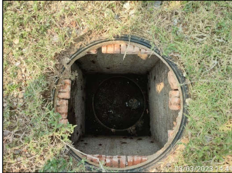
บ่อบำบัดน้ำก่อนผ่านระบบบำบัดน้ำเสียอาคารที่พักผู้โดยสาร
